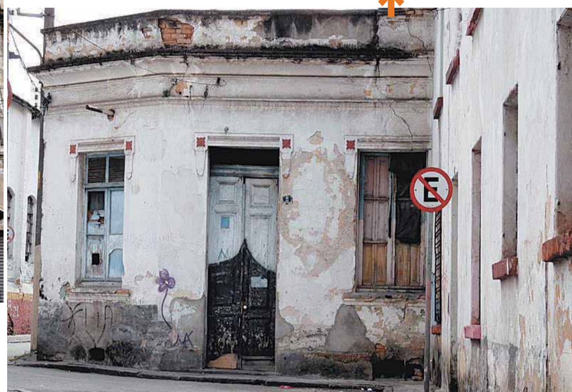
“Construído em 1883, o casarão que hoje está abandonado e corre sério risco de demolição na Alameda Ribeiro da Silva pertenceu ao barão do Rio Pardo”
